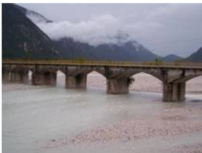
Figura 7 Ponte sul Fiume Fella di uso promiscuo strada - rotaia
