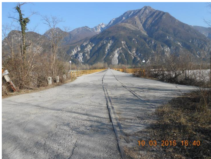
Figura 11 Ponte sul fiume Fella di uso promiscuo strada – rotaia e P.L. N° 2 km 1+290 in comune di Amaro (Foto R.K.)
